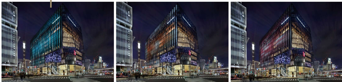
使用約2000台照明器具，搭配41x22格的建築外觀設計。可配合季節、氣候的變化，營造不同燈光效果。
