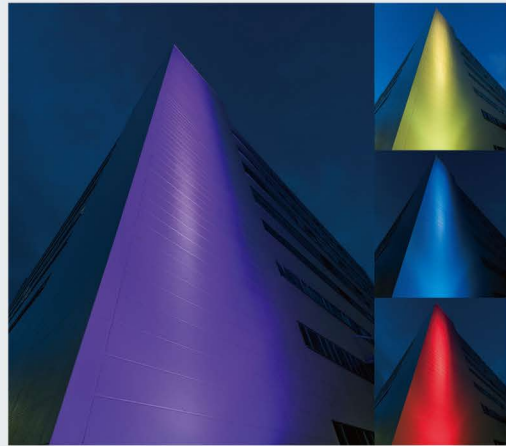
※實際安裝照片(建築物高度40 m)
