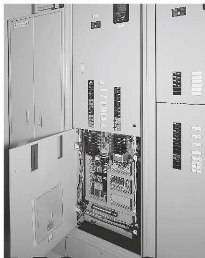
電驛控制盤內部
